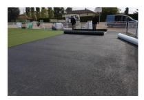
Mise en place du gazon dans les 2 buts à partir des chutes des rouleaux se trouvant aux extrémités du terrain.
