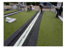
Mise en place des lignes blanches au niveau des découpes du tracé de jeu. Et rabattage des bords des rouleaux de gazon pour jointer et encoller.
